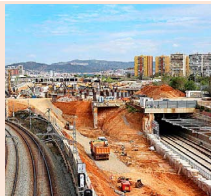
Obras de alta velocidad en España.
